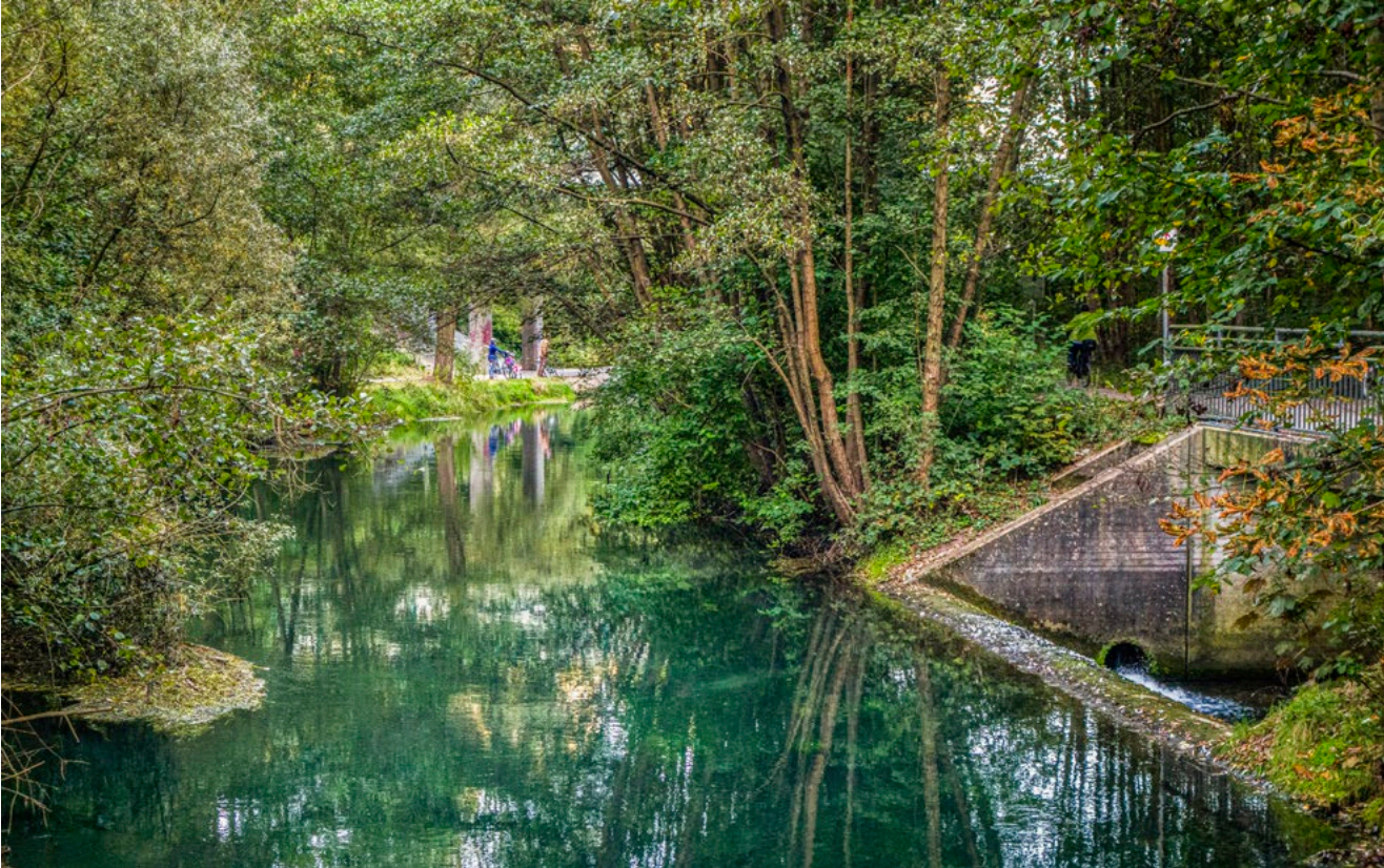
Die Pader-Alme-Überleitung nordwestlich des Padersees · 2015
