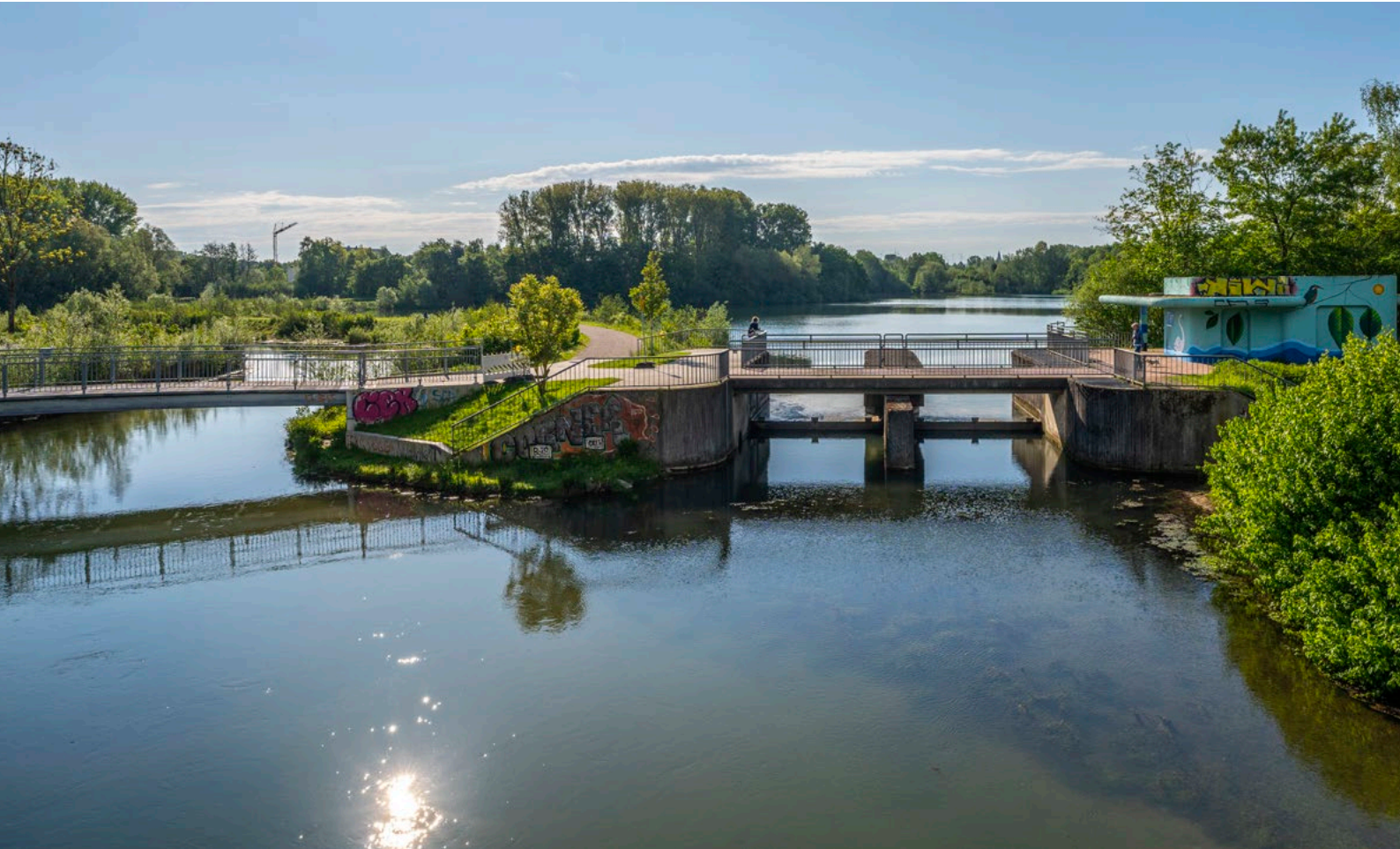
Ein Damm trennt aus ökologischen Gründen die fließende Pader vom stehenden See. ab. Foto: 2023
