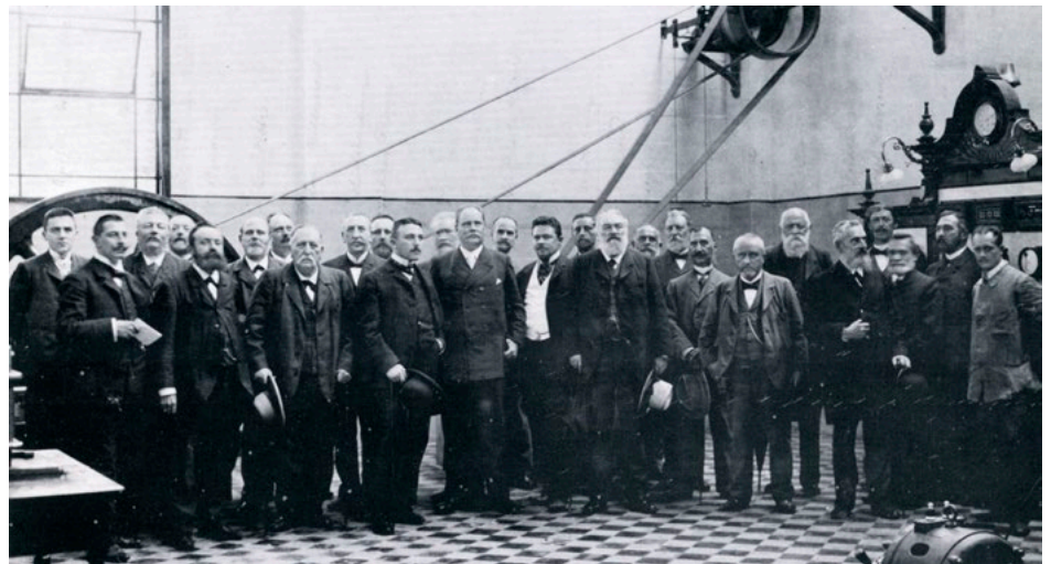
Wasserwerk an der Börnepader: Eröffnung der Ozonanlage 1902. Repro: Stadt- und Kreisarchiv Paderborn (aus: 450 Jahre öffentliche Wasserversorgung in Paderborn. Paderborn 1973)
